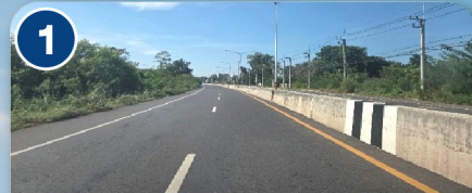
ช่วงก่อนถึง กม.8+400
