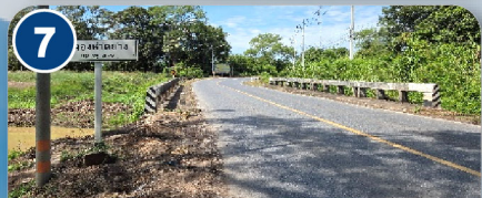
สะพานข้ามคลองหาดยาง กม.12+500
